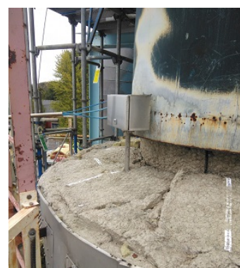
Multipunktsgivaren monteras från ovasidan av reaktorn.
